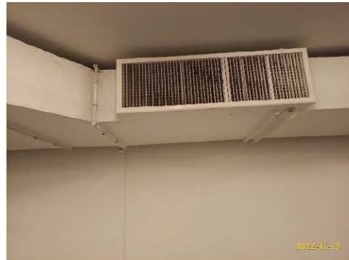
ระบบระบายอากาศพื้นที่จอดรถ (ใต้ดิน-ชั้น 2-4)
