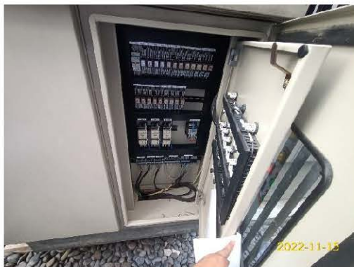
แผงควบคุมเครื่องสูบน้ำบ่อหน่วงน้ำ
