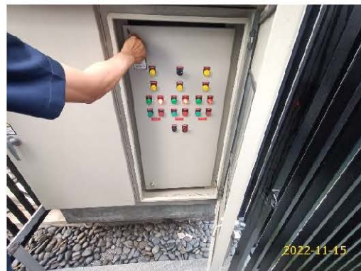
แผงควบคุมเครื่องสูบน้ำบ่อหน่วงน้ำ
