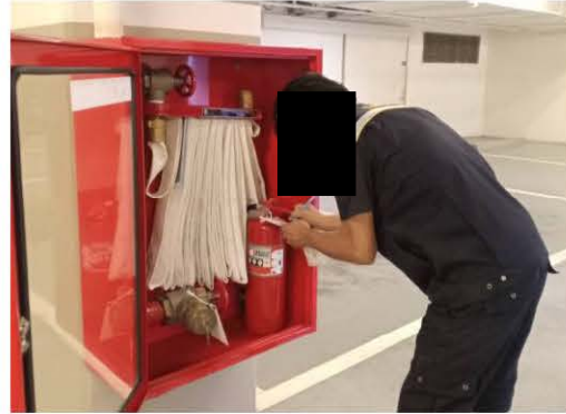
การตรวจสอบระบบดับเพลิง
